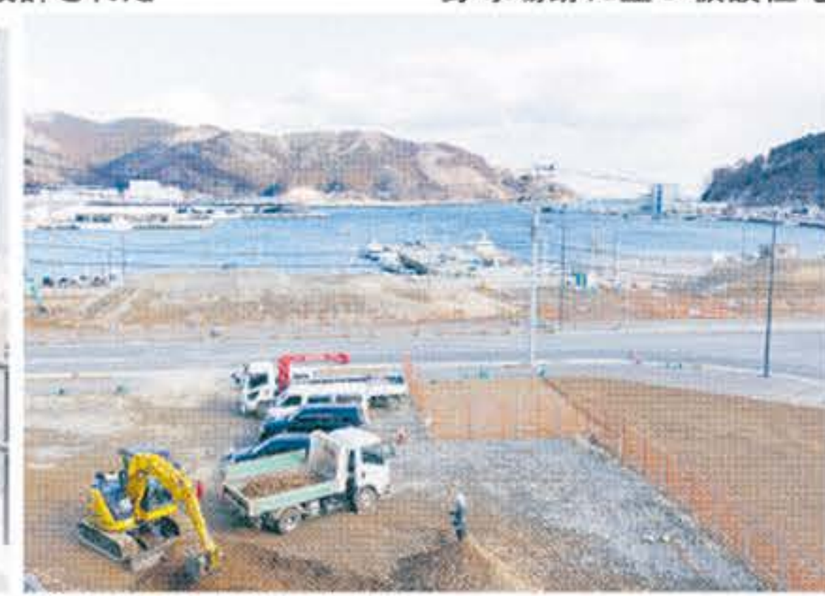
着々と整地が進む造成地
