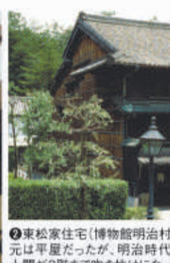
⑧東松家住宅(博物館明治村) 元は平屋だったが、明治時代に3階建てに増築された。土間が3階まで吹き抜けになっている
