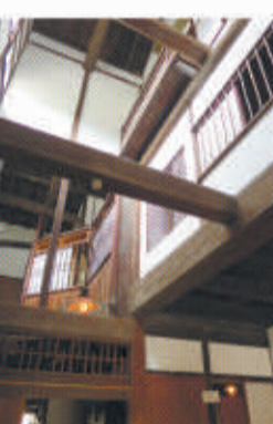
⑨東松家住宅(博物館明治村) 元は平屋だったが、明治時代に3階建てに増築された。土間が3階まで吹き抜けになっている
